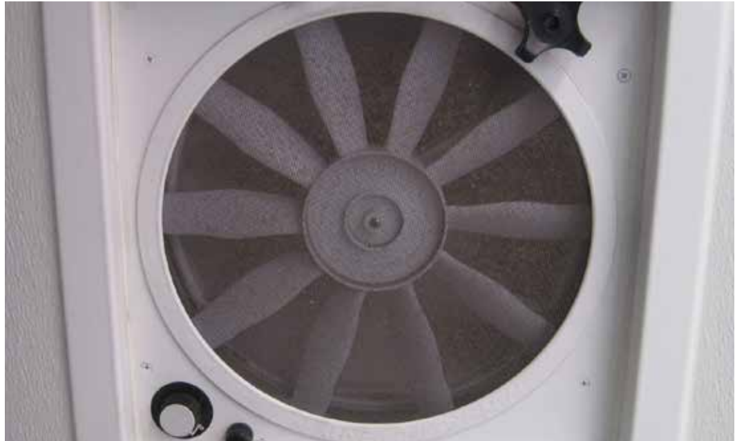
Roof vent and fan
